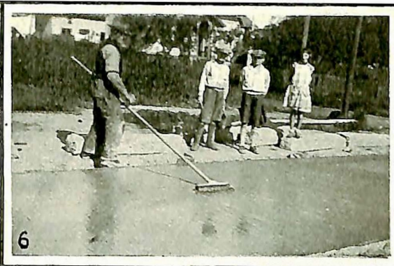
Fig. 6. Cementmelk fjernes; og dekket får fine tverriller.
