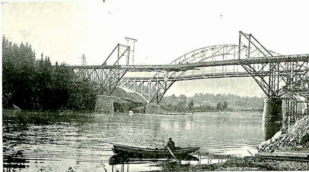
Veibro over Bandakkanalen ved Lunde.
