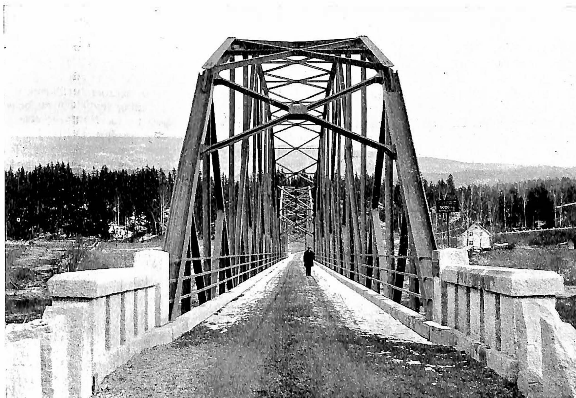
Skotselv bro over Drammenselven, 2 spenn à 84 m., 4,5 m. kjørebredde. Samlet jernvekt 248 tonn. Bygget 1928
