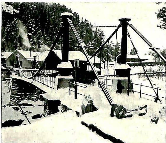
Åmot bro, Buskerud fylke. Hengebro med kjeder av flatjern, sammensatt ved boltforbindelser. Spennvidde 54 m. Bygget 1856.
