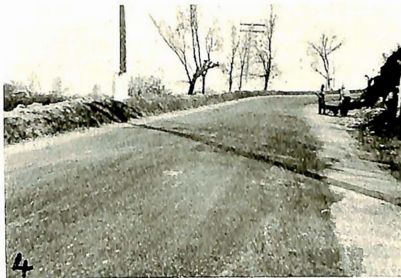
Fig. 2. Merkning i kurver. Fig. 3. Asfalddekket med betongkanter. Fig. 4. Jordvollrekkeverk i kurve. Fig. 5. Grusspredervogn.
