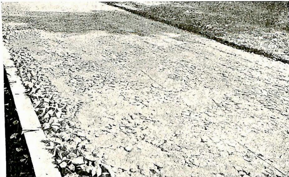
Fig. 2. Overflatens utseende etter et par ganger valsning. Bemerk de steder hvor der ytterligere kreves påfyllning av *tor* alcementmørtel.
