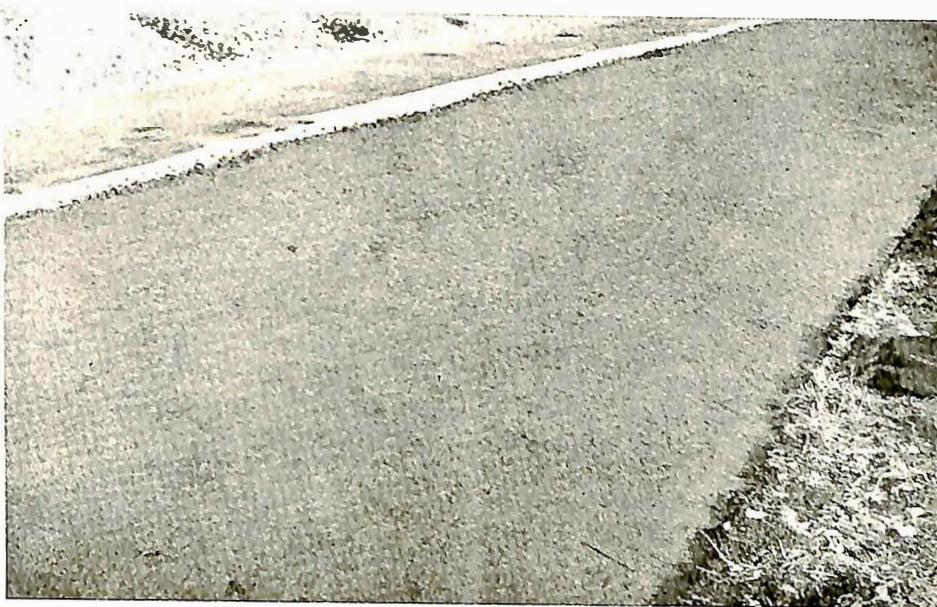
Fig. 4. Det ferdige veidekke. Kan trafikeres 24 timer etter påbegynt vanning. Bemerk den ru overflate.
