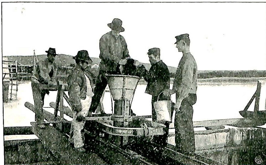
Betonstøpning ved pillar III.
