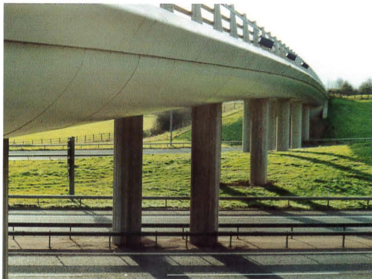
Vegbrua kledd inn med glassfiberarmert komposittmateriale som underdekning.
