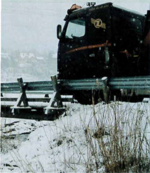
an oppdaget at trebrua var i ferd med å løsne og ds tid. Her den midlertidige Baileybrua for sykklist 500 000 kr vil bli påbegynt når vinteren er over.
