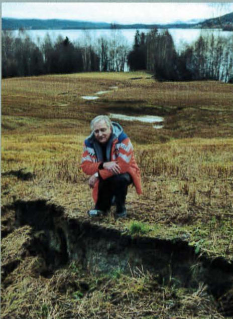
Geotekniker Cato Solberg ved Bjertnes i Krødsherad. En underjordisk elv vasket bort masser i grunnen – noe som medførte betydelige nedsynkninger på jorden i bakgrunnen og på Rv 7.
