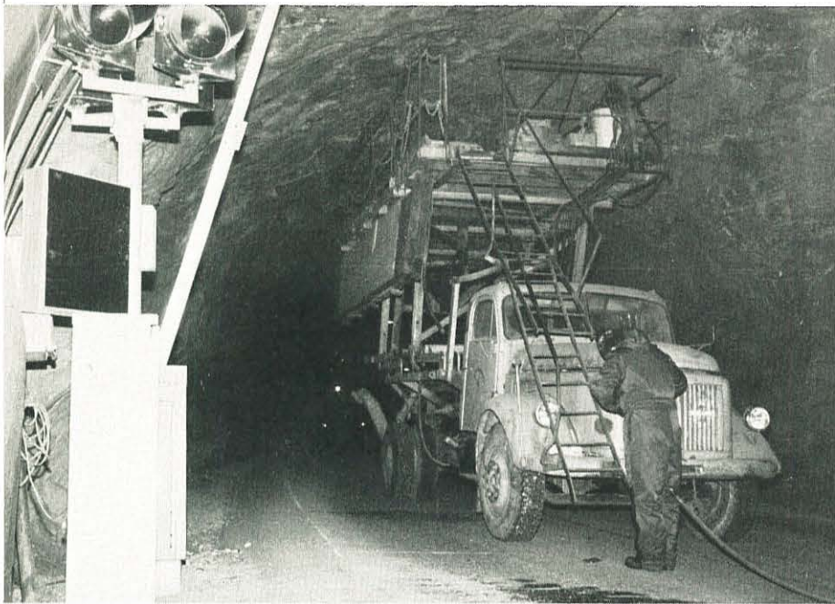
Montering av antennen i Austmannalitunnelen.
