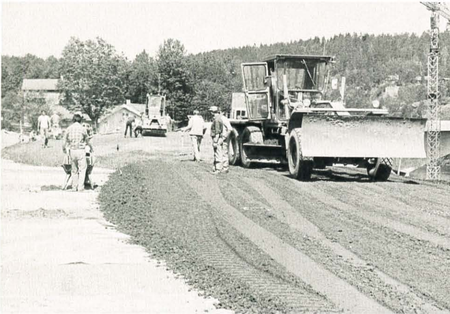
Utlegging av kombinert bærelag og dekke samtidig. Denne valsebetongen er av meget tørr betong. Under legges fiberduk for hver sjette meter – som skal hindre opp-pumping av finstoff fra underlaget.
