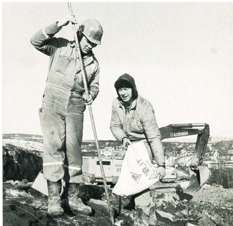
Av hensyn til rystelsene fyres det bare av mindre salver i Bånnåsen i Porsgrunn. Tore Mobbek og Sverre Røsvik gjør klar til en ny salve. I alt er omlag 7000 kubikkmeter fjell sprengt ut i Bånnåsen.
