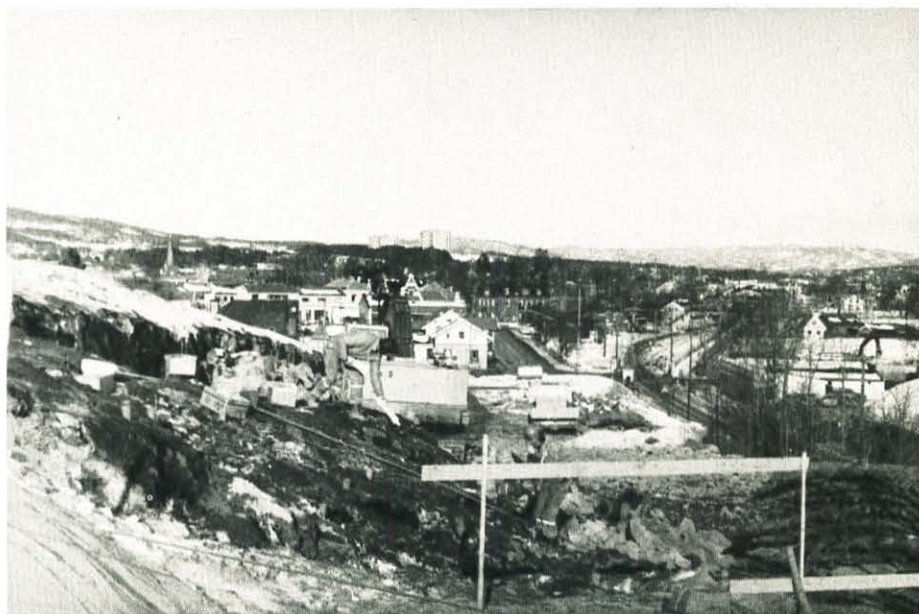
Her skal vegen ligge. Nyvegen skal være en direkte fortsettelse av Jernbanegata i bakgrunnen. (Fra Porsgrunn.)
