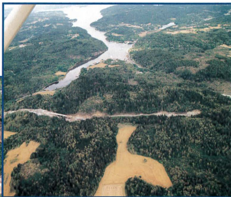
Påkobling E6 ved Vassum (Frogn). Nordbytunellen til høyre
