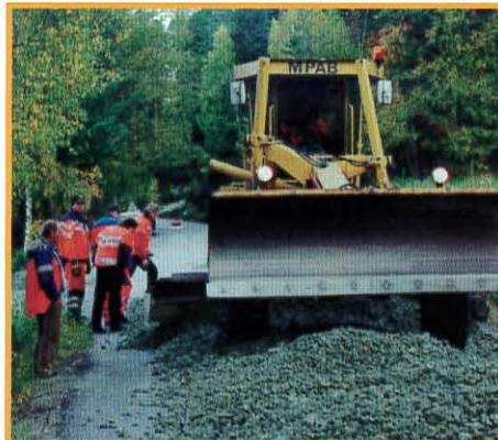
Skumglassmassen kjøres ut på toppen av eksisterende dekke, og jevnes ut med hovel til tolv centimeters tykkelse.
