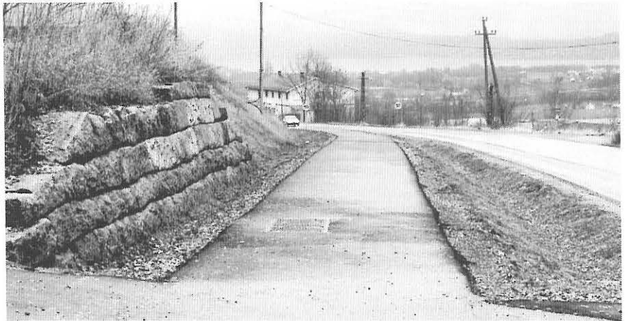
Steinblokker fra den gamle jernbanen i Lier, er brukt langs den nye gang- og sykkelvegen.
