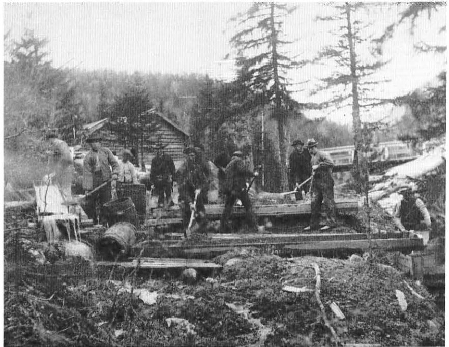
Fra ombyggingen i 1900. Her lages betongen. I tretønnene til venstre på bildet, er det sement. Forøvrig er vel utstyret noe annerledes enn det som brukes i dag.
