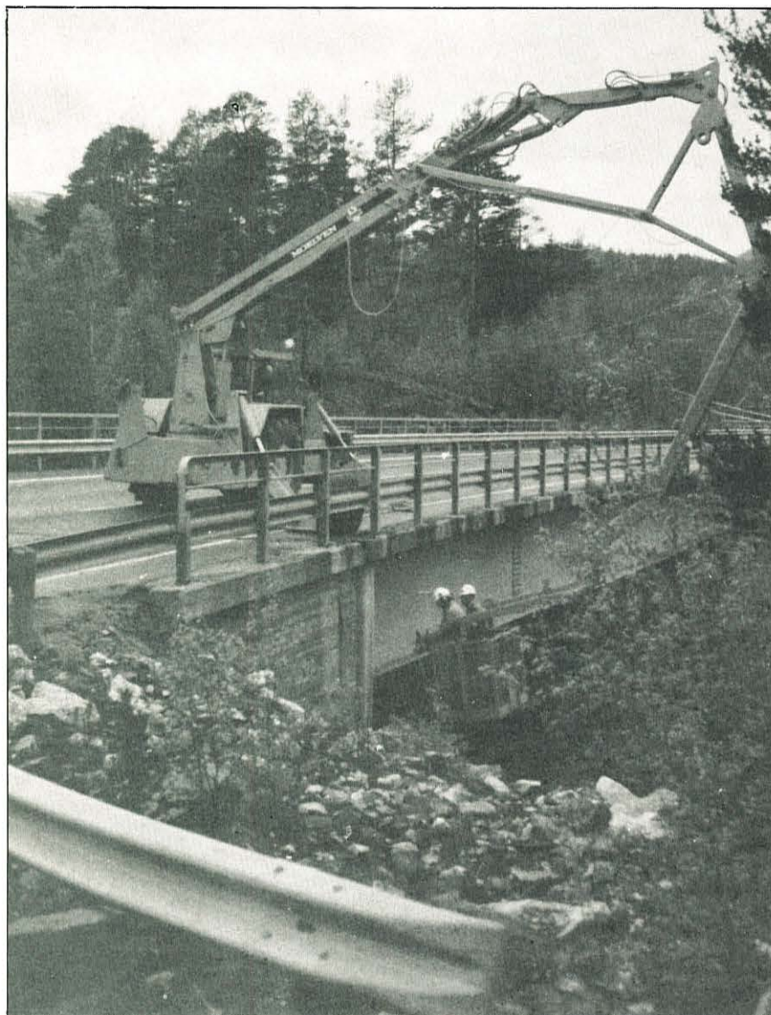
Den nykonstruerte krana gjorde det enkelt for «inspektørene» å komme inn under bruene. Foto: S. Helgesplass.
