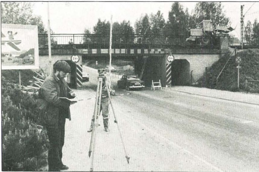
Ing. Tore Hodnebrug gjør sine beregninger før arbeidet settes igang.
