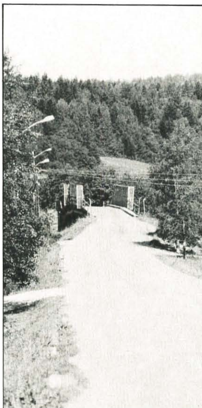
Til høyre den gamle brua som er smal og svært vanskelig å passere, særlig på vinterstid.
