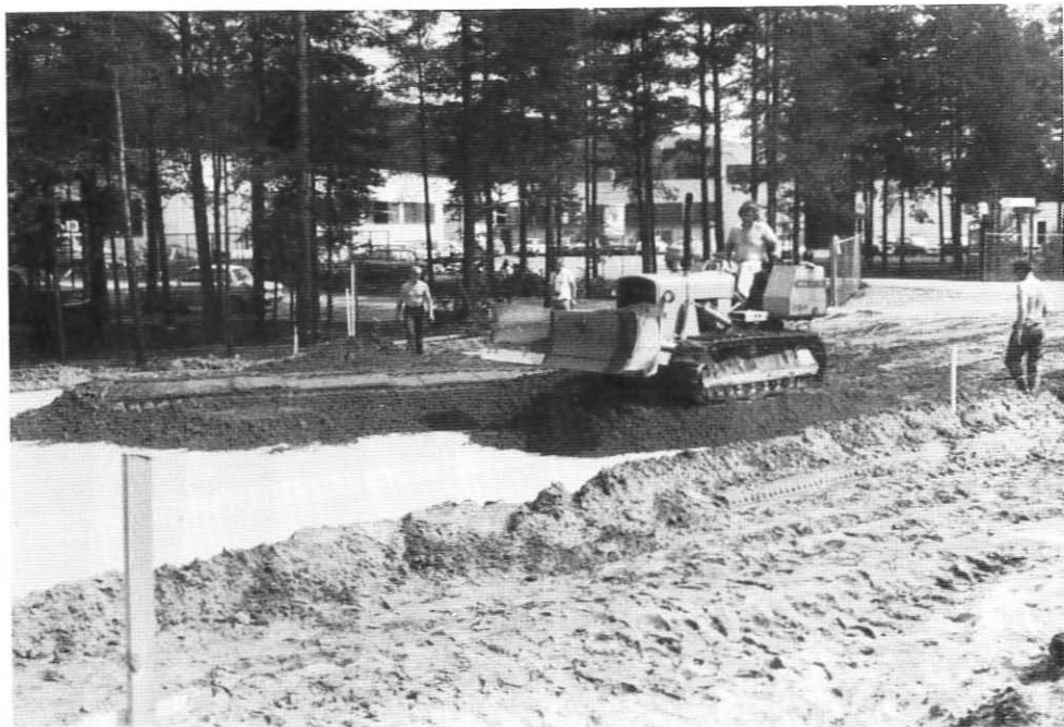
Utlegging av soilsement på plater.
