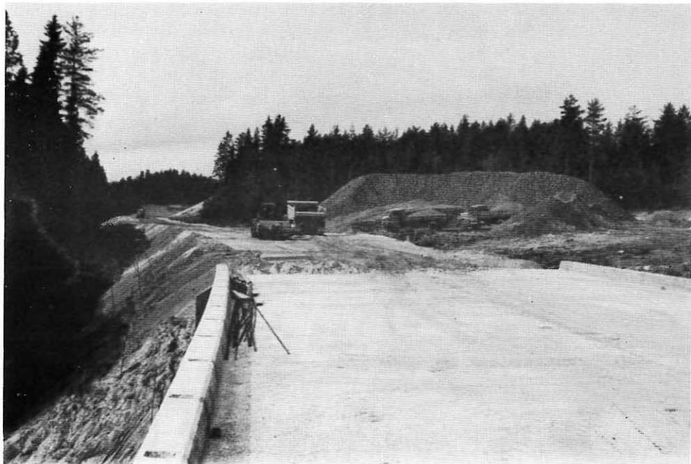
Fra riksveganlegget Åmot - Bottegård.
