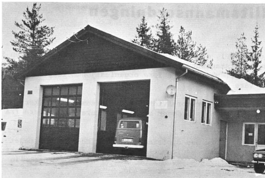
Kontrollstasjonen på Gol.
