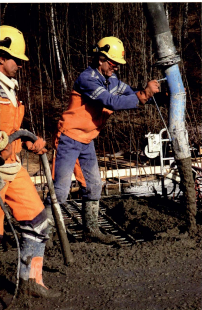
Tore Dybendahl (formann) styrer "tuten" på betongpumpa. Det er Roger Strand som bruker betongvibrator'n. Vibrasjonene fjerner luftlommene og gjør at betongen blir massiv.
