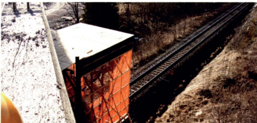
Det kunne blitt katastrofalt dersom noe falt ned på skinnegangen eller på et av togene som passerer under brua. Veidekke har derfor bygd en liten tunnel av tre som beskytter tog og skinnegang. Tunnelen er midlertidig og skal fjernes når brua er ferdig.
