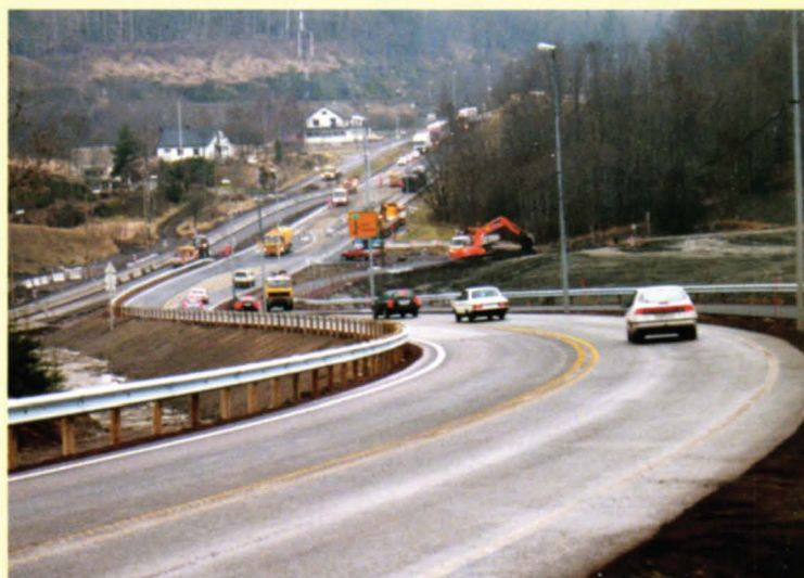
Den midlertidige Hellandbakken sett sørfra. Gamle E18 til venstre (Foto: Dag Runar Haugen)
