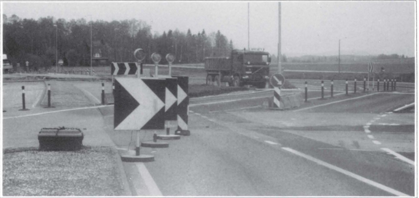
Interimsvegen i krysset E 18/riksveg 319 til Svelvik blir fjernet når pinsetrafikken setter inn for alvor, sier Einar Lunde til Vestfolder'n. Arbeidene med undergangen er beregnet ferdig til St. Hans.
