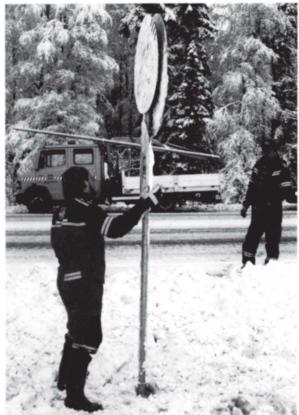
Gunnar Hansen og Lasse Støvland kan konstatere at det nye skiltet av den nye fleksible typen ikke holdt mål.
