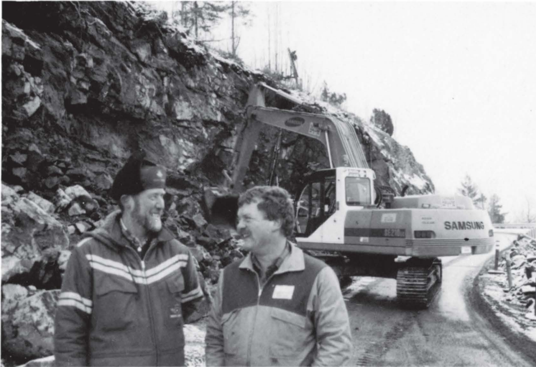
Her ser vi Vegvesenets mann Øivind Myhre (t.v), sammen med sprengnings-eksperten Tor Aage Bræin foran fjellskjæringen i Høyjord.
