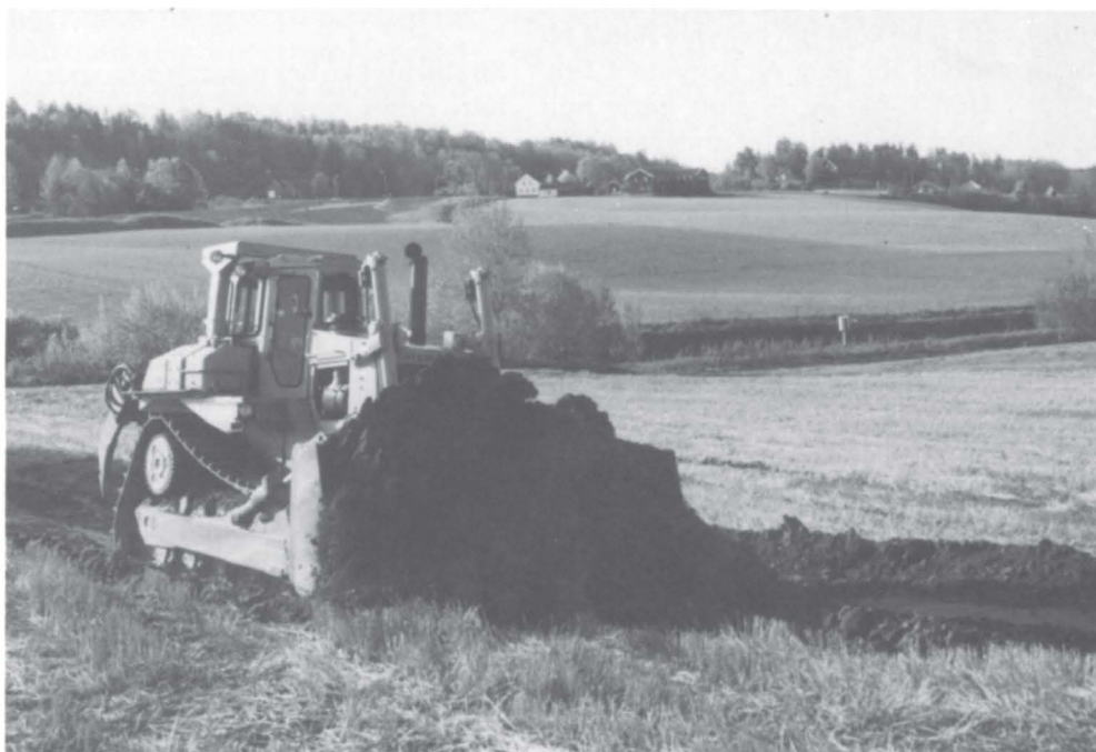
Arbeidet er i gang på Kombinasjonslinjen. Aksjonene medførte bare små tap og forsinkelser for Vegvesenet.
