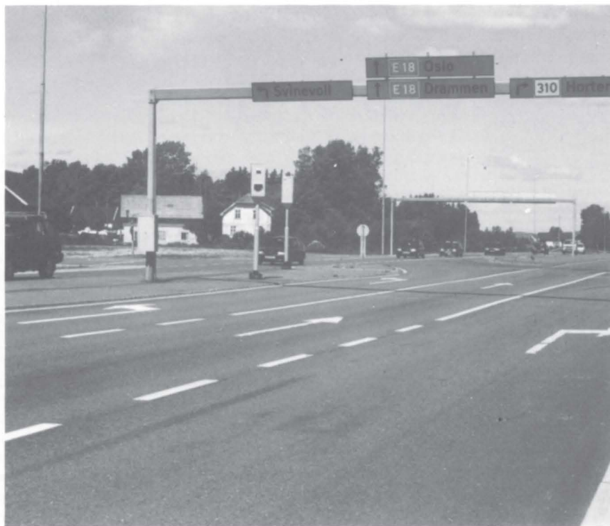
Motorveg gjennom Kopstad-krysset flere kan bli bygd flere år før resten av parsellen.
