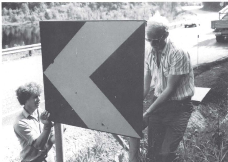
Retnings- og bakgrunnsmarkeringene som ble satt opp i 36 kurver i perioden 1984-87 har redusert utforkjørings- og møteulykkene med 48 %.
