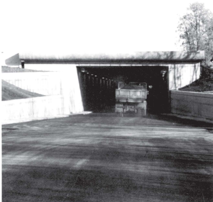
Miljøtunnelen på 700 meter er en unik konstruksjon på norske veger.
