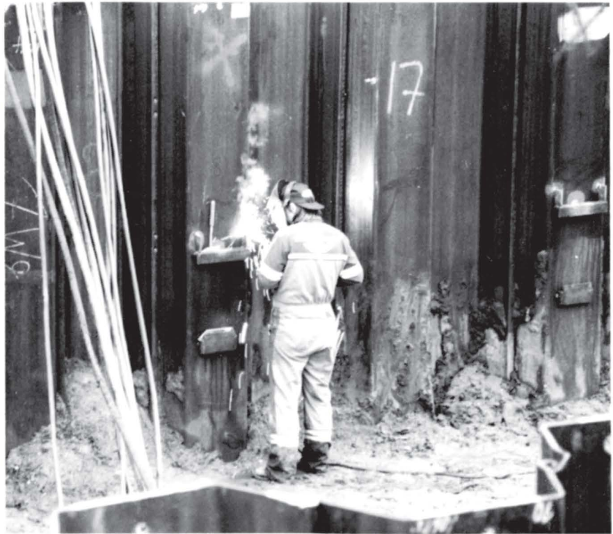
En stålbjelke skal sveises fast til spuntveggene. På den skal forskalingsvogna monteres. På bildet er Morten Guldbrandsen fra maskinavdelingen i gang med sveisingen.
