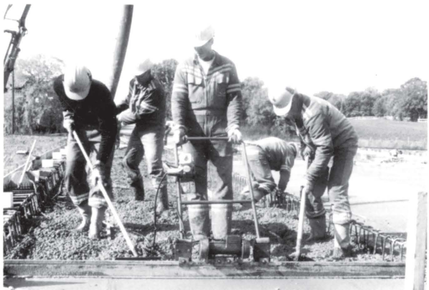
8. september ble Langgrunn bru som er en tversgående bru på Sydoverveien støpt.
