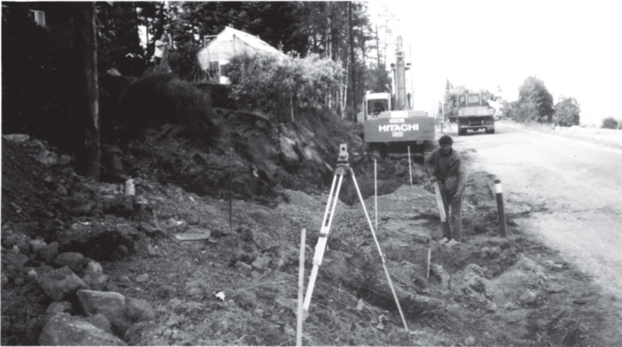
Underentreprenør Jan Meland rydder, etter masseuglidning, som var en følge av trauing til forstøtningsmur.
