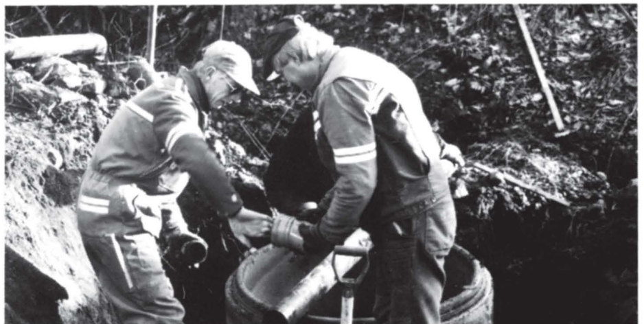
Ragnar Fostrød (t.v.) i arbeid med omlegging av kloakken langs riksveg 312.
