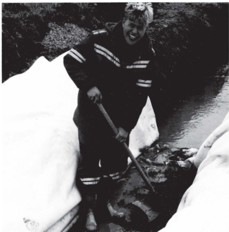
Her er Arve Kirkevold igang med grøftarbeider på vestre siden av fylkesvegen.
