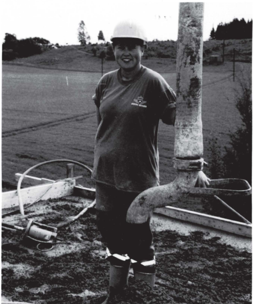
Heidi Haugland er lærling i driften. Her under støpingen av Gjennestadmyra bru.
