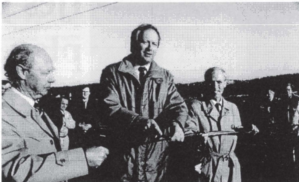
Ordfører Arild Lund åpnet Elveveien 11.11. Vegen løser et lenge følt transportproblem i Larvik.
