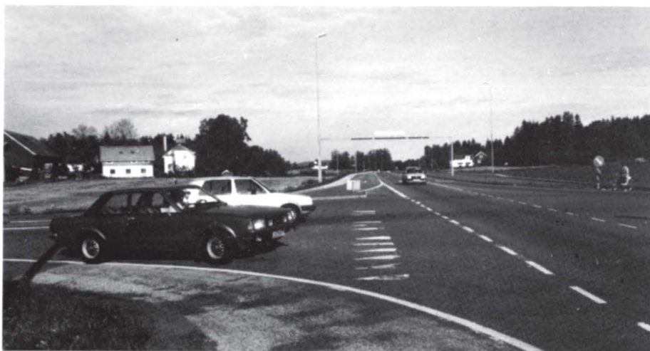
Mange uhell i forbindelse med venstresvinger eller kryssinger på E 18 i Kopstad-krysset i Borre.
