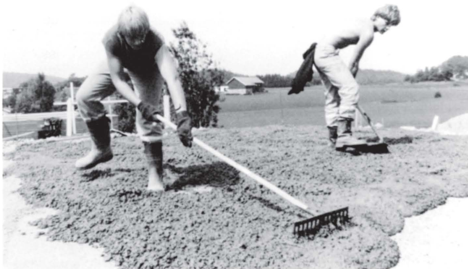
Vidar Hårstad (t.v.) og Kenneth Gjermestad tok fagprøven på sålen til det sydlige landkaret på Fadumvegen bru på E 18-anlegget.
