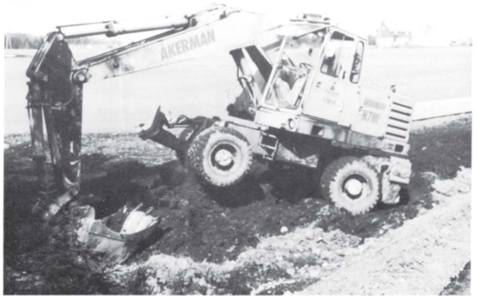
Vegvesenets gravemaskiner konkurrerer med private maskinentreprenører og klarer seg svært bra.
