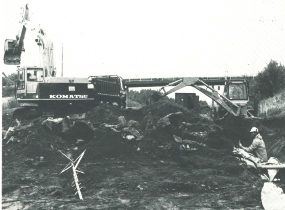
Utbedringsarbeidene på motorvegen i Sandefjord ble omfattende.
