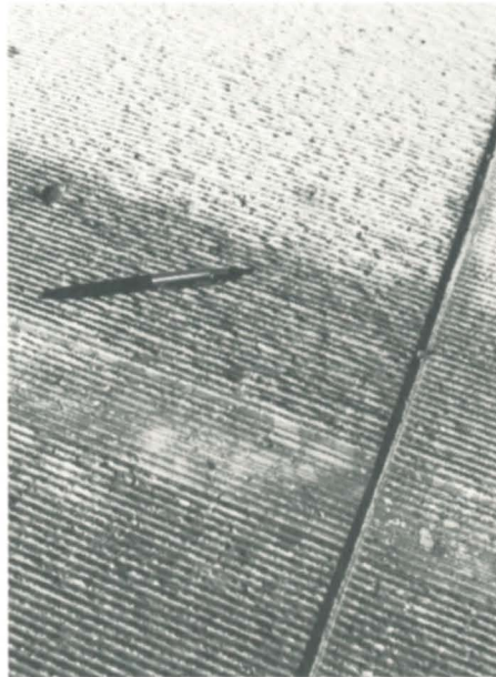
Dette er resultatet etter saging av betongdekke over fugen.
