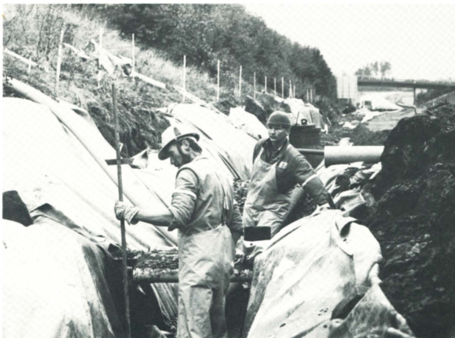
Dreneringen er viktig for å holde vannet ute fra vegkroppen. Øyvind Myhre og Trond Ove Bergstrøm passer på at dreneringsrørene blir liggende riktig.
