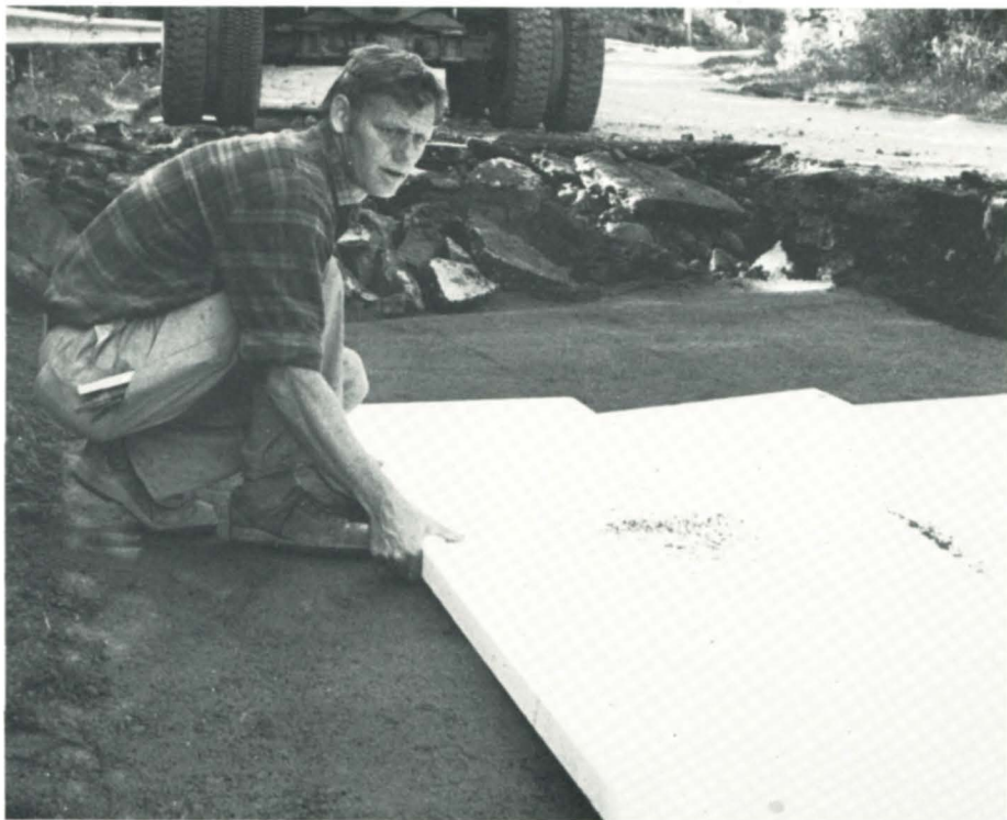
Hans Kristian Olsrød legger ned 5 cm tykke isolasjonsmatter på de stedene hvor vegen har vært dårligst. Disse mattene er viktig hvis vi skal få bukt med teleproblemene.
