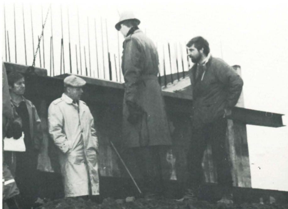
Befaring på anlegget.
