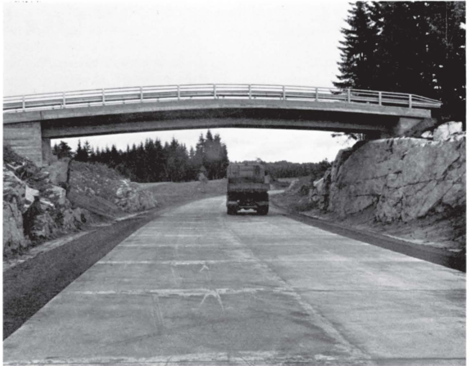
Vegstandarden på den nye E-18 parsellen i Sandefjord har blitt en del kritisert både m.h.t. kurvatur og vegbredde.
