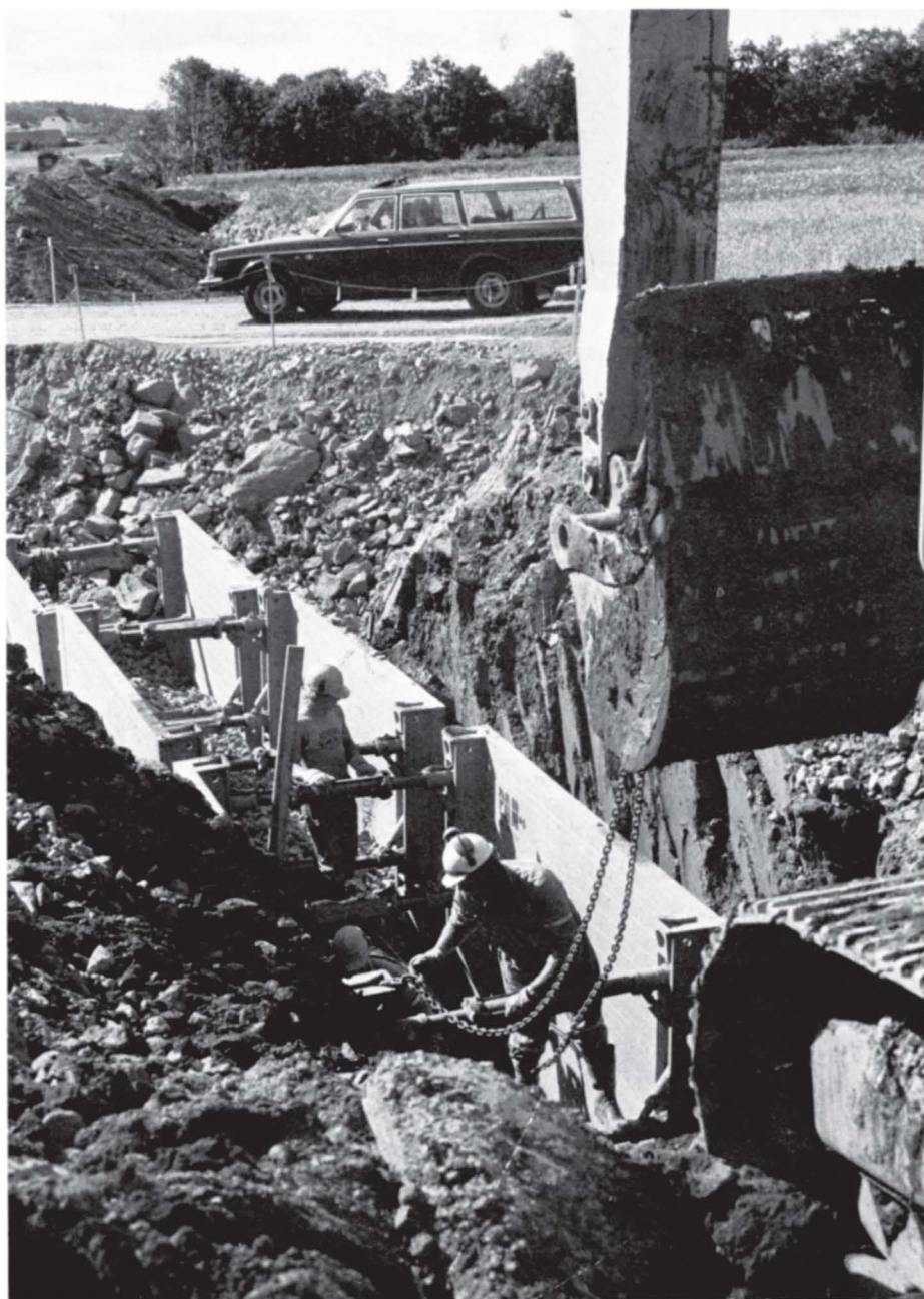
Det er viktig å sikre de som arbeider nede i dype grøfter. Derfor ble det prøvd ut avstivningsutstyr. Utstyret ble så godt mottatt at det ble kjøpt inn.
