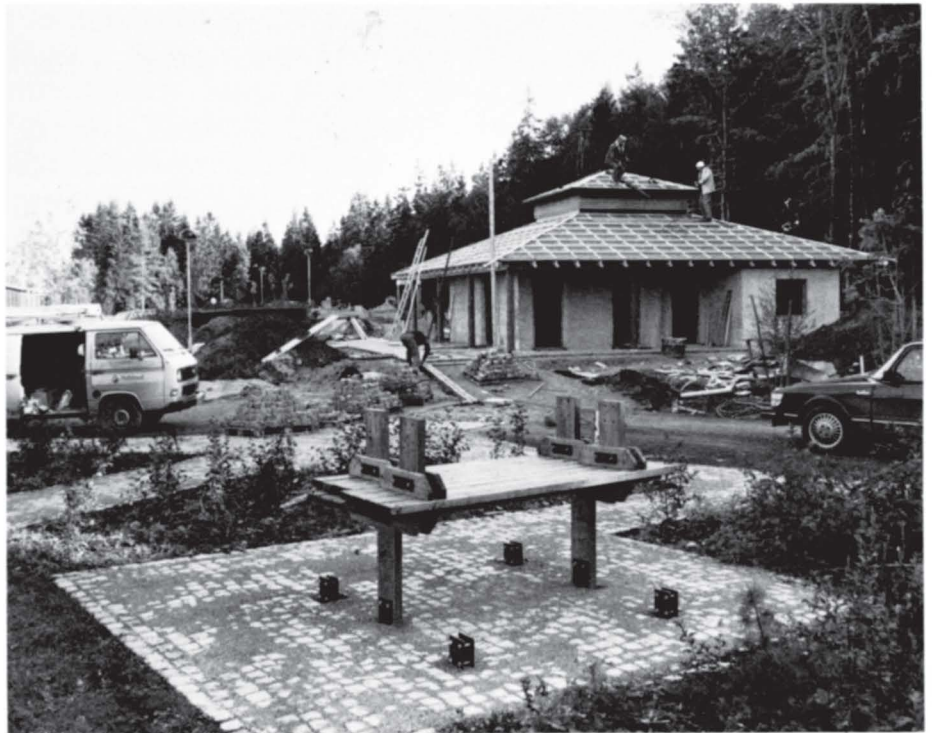
Det moderne toalett- og servicebygget på rasteplassen begynner også å ta form.
