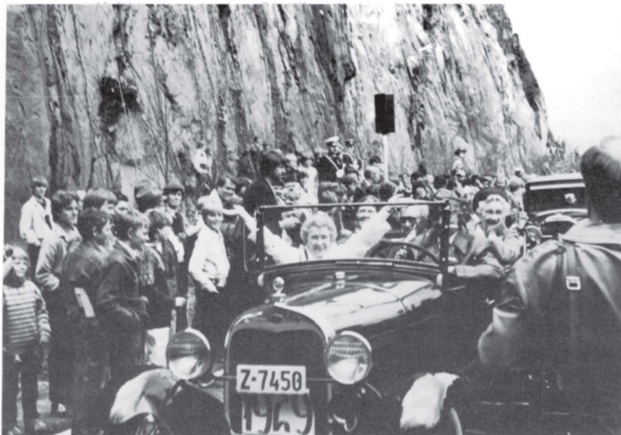
E 18 anlegget i Holmestrand er det største enkeltprosjekt som er gjennomført i Vestfold. Åpningen ble en folkefest hvor mange tusen mennesker deltok.
