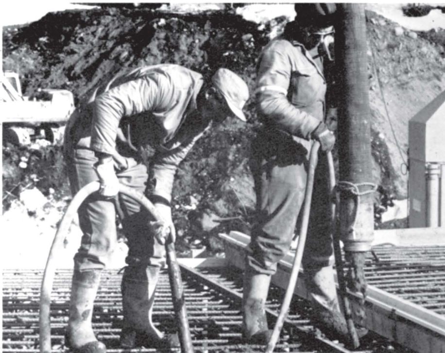
Harald Wessel og Finn Tore Li støper på en av de bruene på nye E 18.
