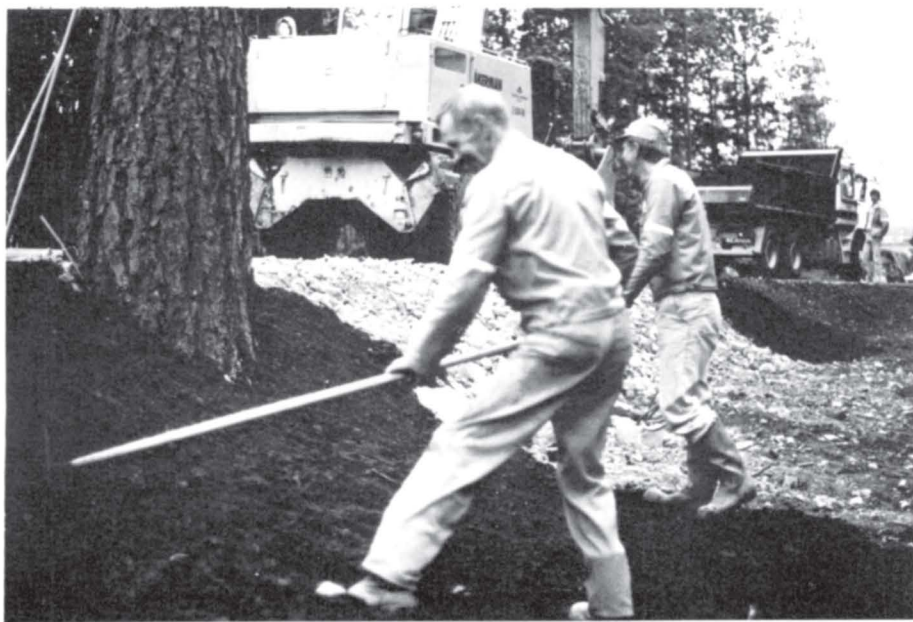
Gunnar Nordkvelle og Odd M. Andersen er i gang med finpussing av vegskråningene.
