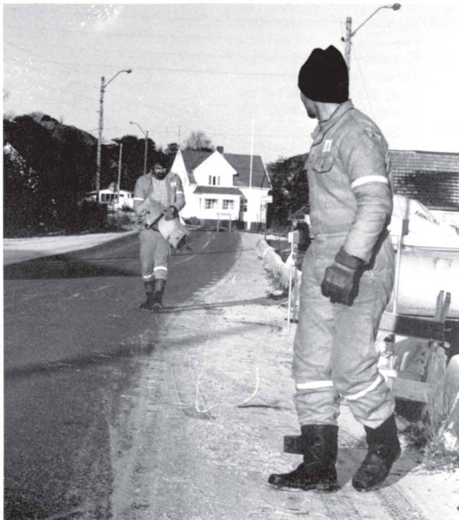
Trond Carlsen og Allan Kristiansen utbedrer skader på Tjøme sist vinter.
