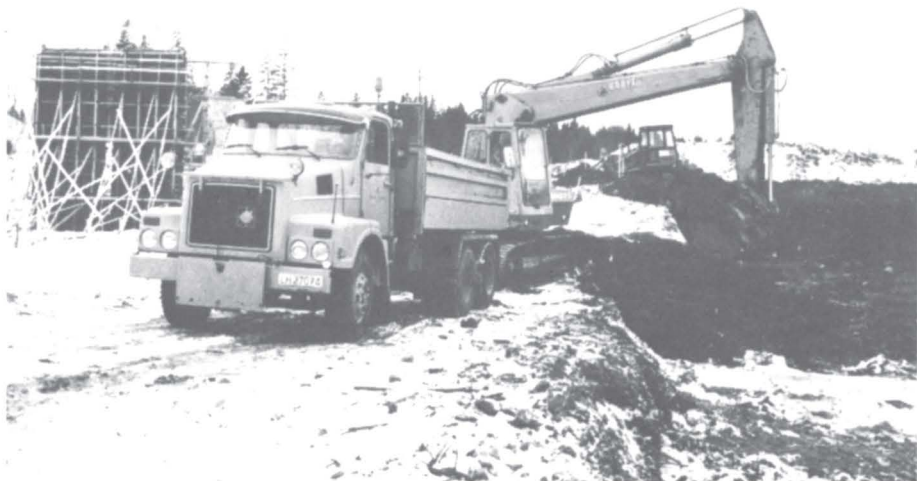
Anleggsarbeidene ved den nye trafikkmaskinen i Foksrød er i god gjenge. I bakgrunnen sees en av brukarrene.
