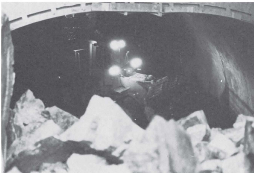
En titt ned i tunnelen der hjullasteren er i full gang med opplasting av masser.
