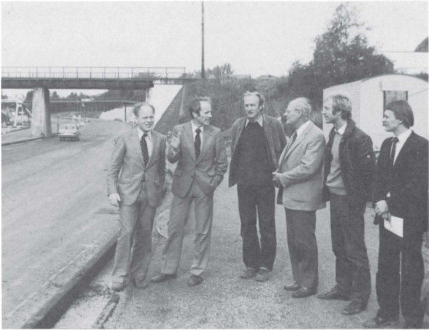
Oppsynsmann Odd Arntzen og anleggsleder Einar Hansen viste rundt på veg-anlegget i Sandefjord.
