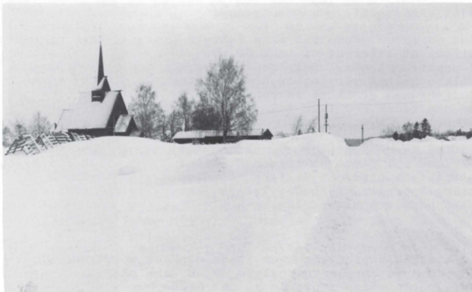
Riktig plassering av snøskjermer ved Høyjord stavkirke.
