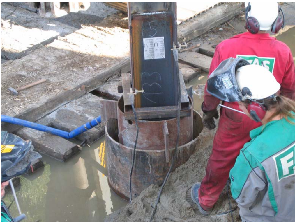
Figur 29 Ramming av H-bjelker med rørstyring innsnevret i toppen med firkantrør
