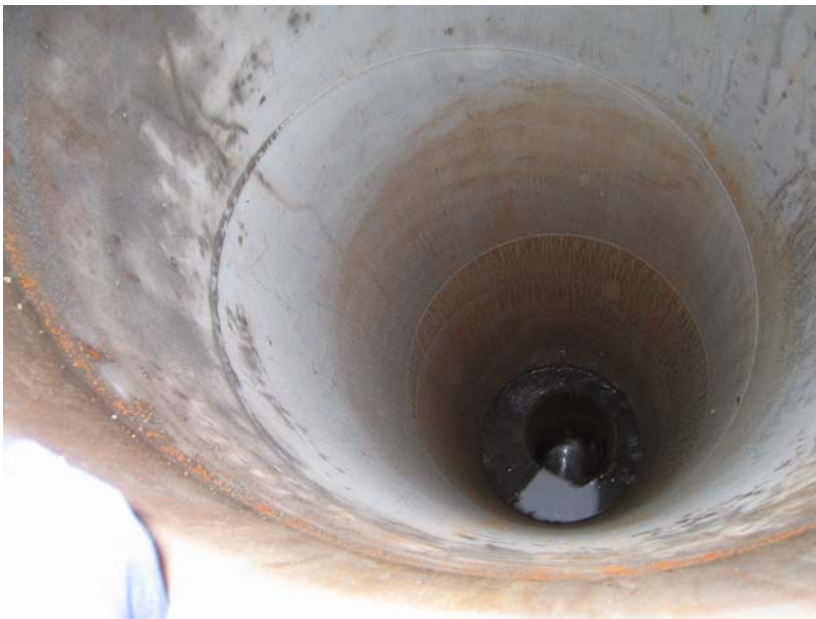
Figur 26 Pel i akse 8 - rør i rør med lav vannstand
