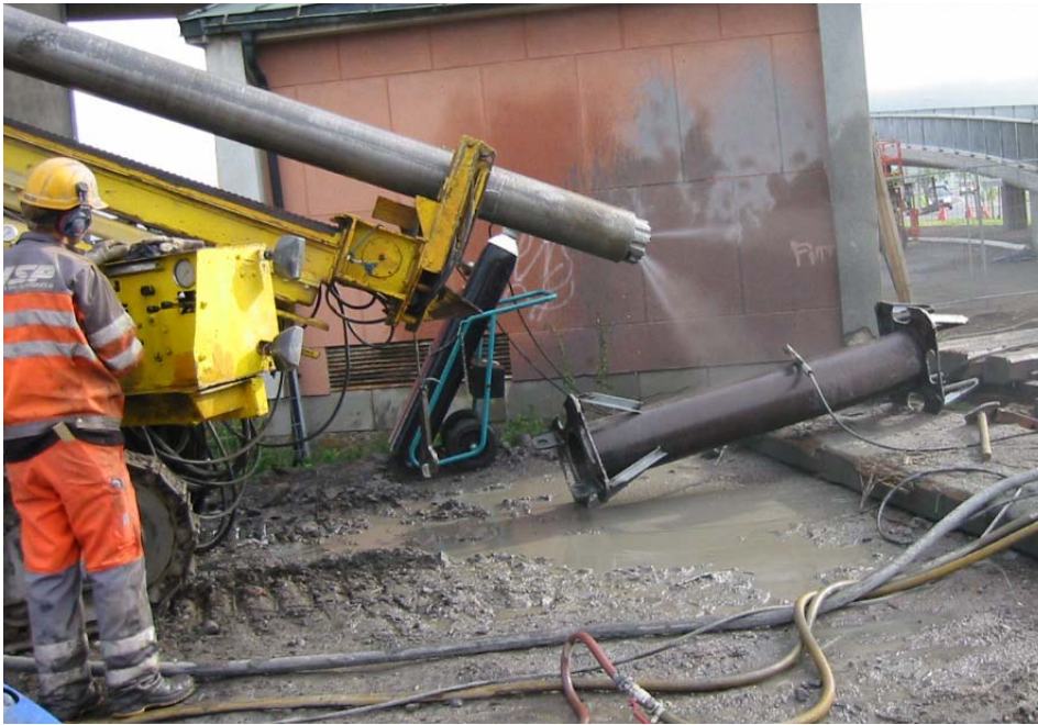
Figur 21 Boring av foringsrør med odex. Styringen ligger på bakken foran borryggen.
