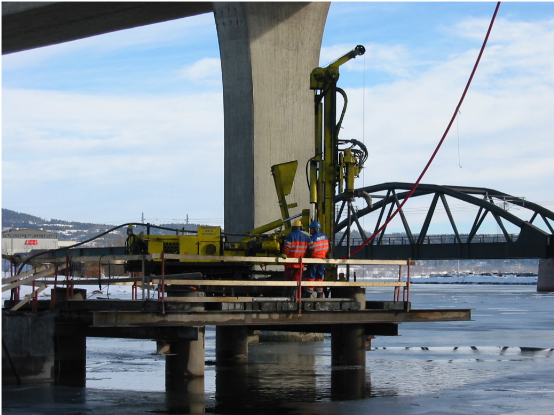
Figur 23 Boring av odex- eller symmetriskrør i fjell
