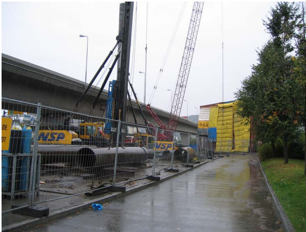
Figur 13 Støyskjerming med containere og lydmatter
