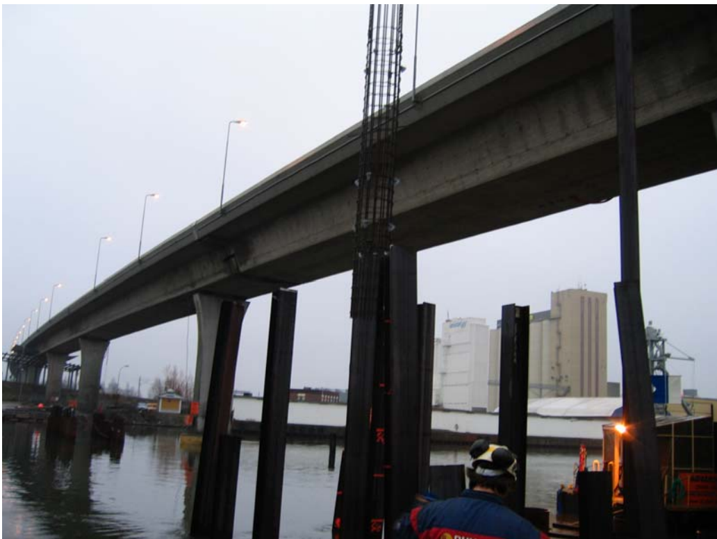
Figur 33 Armering tres på H-bjelken før, kapping og utstøping av stålrør
