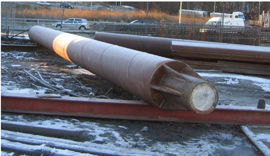
Figur 17 Erstatningspel med diameter 711 mm og gjenstøpt spiss
