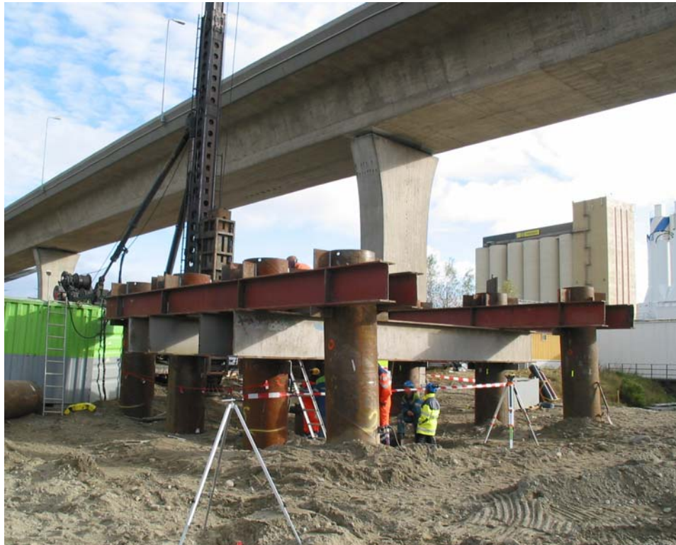
Bilde 1 Prøvebelastning av peler.
