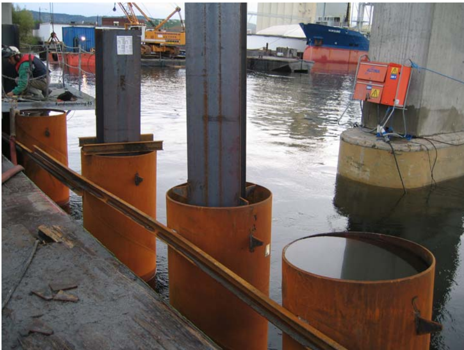
Figur 31 Ramming av H-bjelker med styrebricker
