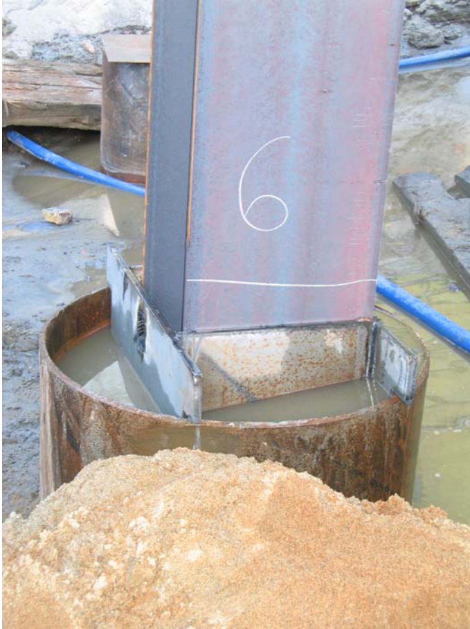
Figur 30 Ramming av H-bjelker med firkantstyring
