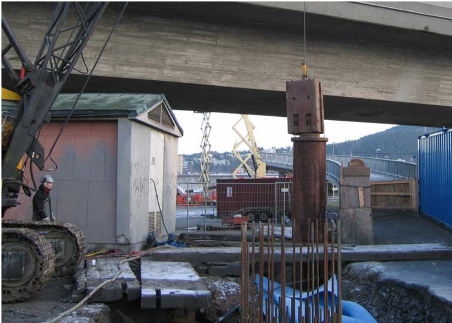
Figur 18 Ramming med enkelt fallodd
