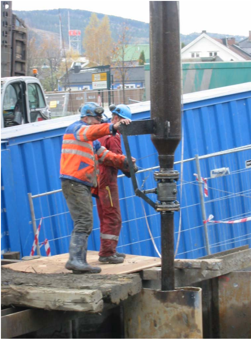
Figur 25 Støping av propp med spesialdesignet betongtobb
