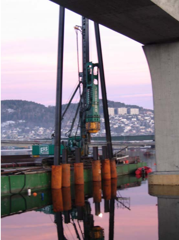
Figur 32 Pelerigg på flåte i elveløpet
