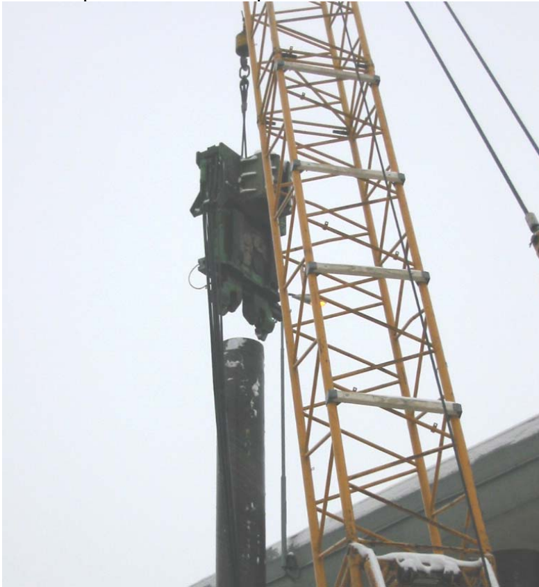
Figur 19 Vibroloddet settes på plass på toppen av pelrøret
