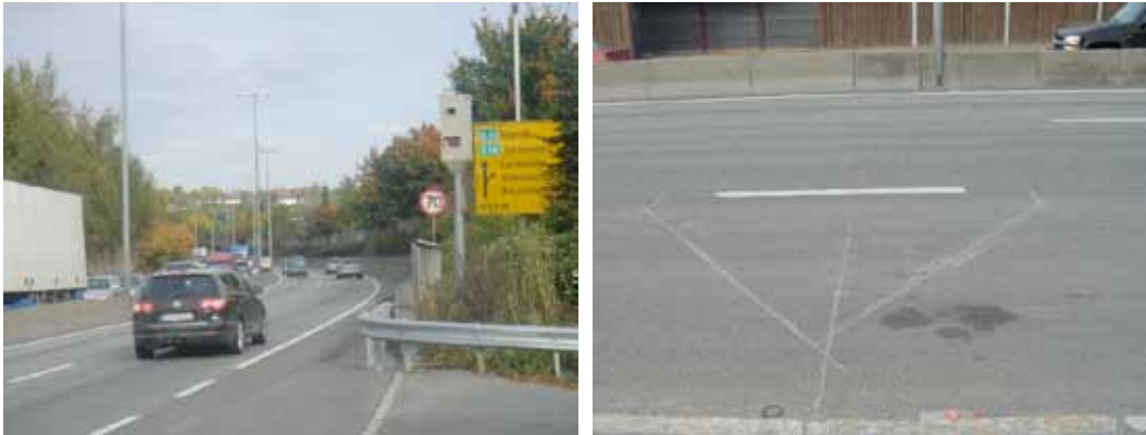
Figur 4.22 ATK-punkt med fotoboks og freste spor for detektorer
