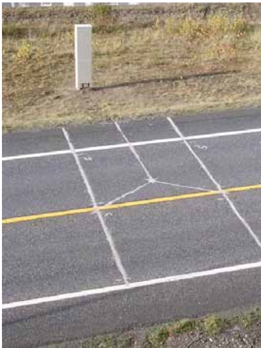
Figur 4.8 Nedfreste piezoelektriske kabler
