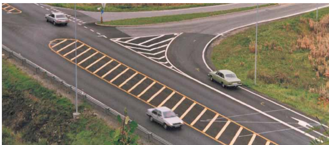
Figur 4.10 Eksempel på bruk av piezoelektriske kabler ved registrering i kryss.
