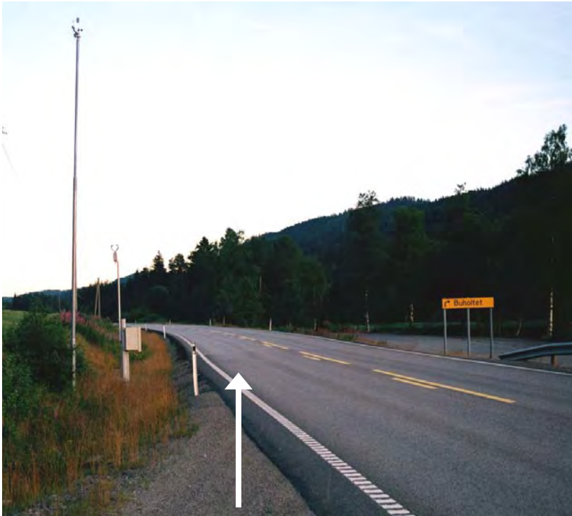
Figur 8. Vegbanetemperatursensoren monteres mellom hjulspor og vegkant.
