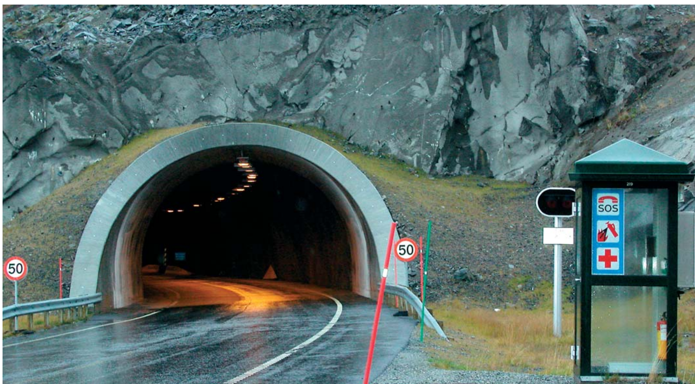
Tunnelåpning, Honningsvåg tunnelen på Magerøy
