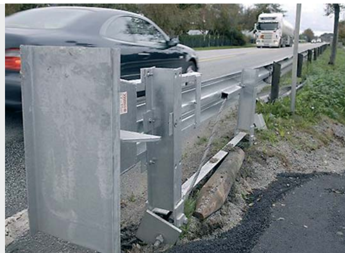
Endeavslutning EuroET uten deksel
