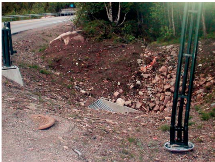
Rv 23 Oslofjord-forbindelsen. Vegutstyr er plassert der hvor sannsynligheten for utforkjøring med MC er størst, i utgangen av rundkjøringene.
