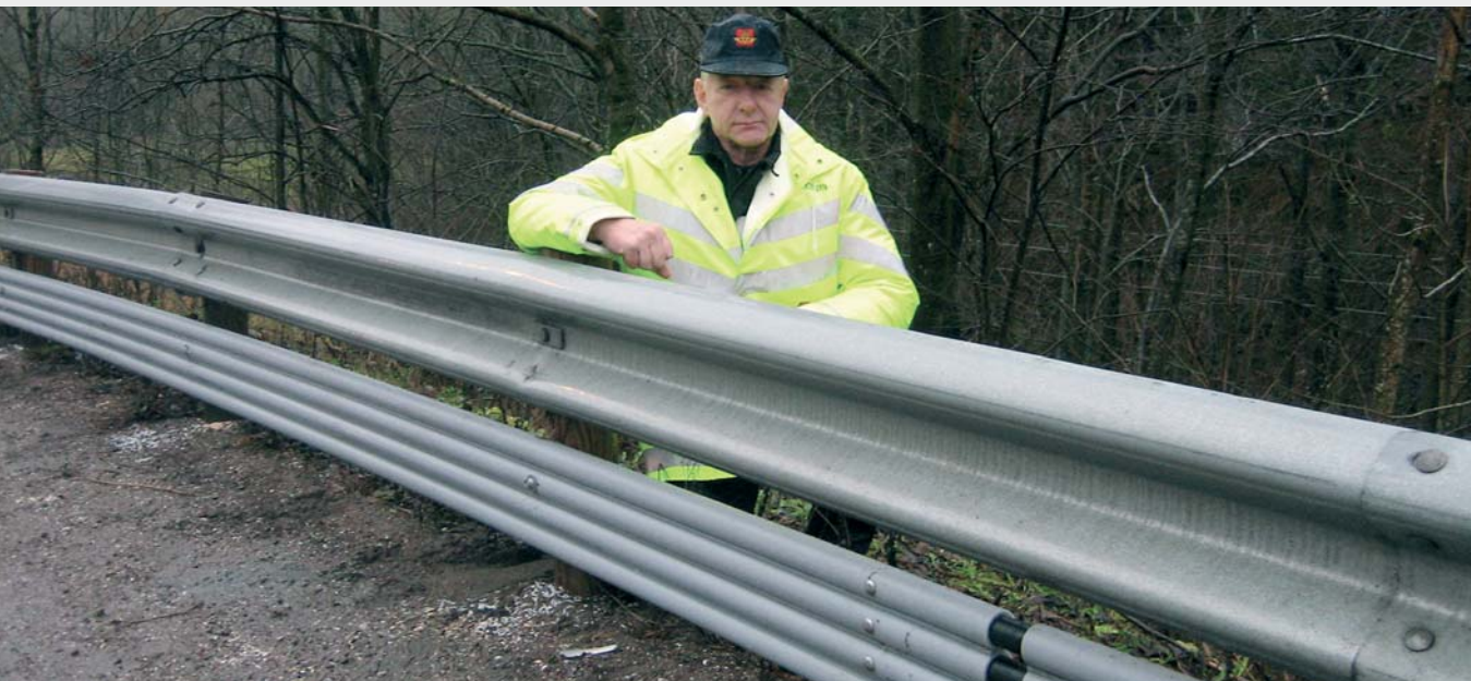
Norskprodusert underskinne, montert på prøvestrekning Skien-Siljan (Telemark).
