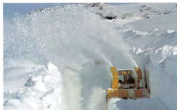
Vinterbrøyting, Sognefjellet. Foto: K. Skagen
