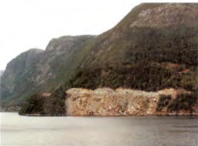
Ved bygging eller utvidelse av veger i krevende terreng blir ofte sårene store fordi arbeidene skjer maskinelt. Billig masseforflytting gjør at det er mer økonomisk med store skjæringer og fyllinger enn mindre inngrep avgrenset av murer. Vadheim i Sogn og Fjordane. Foto: Ukjent
