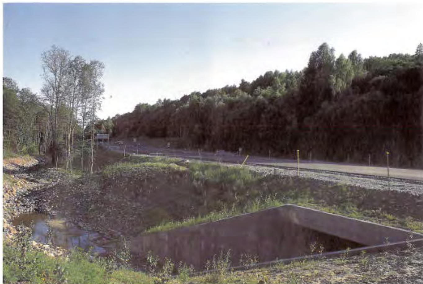
Ved Vinterbru i Ås, Akershus, ble det i forbindelse med planlegging av ny trase for E6 foreslått å lukke Årungsaelva på en strekning over 200 m. Dette ville ha vært et negativt inngrep i et verdifullt vassdrag som har oppgang av sjøørret og laks. Elva ble lagt i et nytt leie langs vegen spesielt utformet for å gi gode oppvekstvilkår for fisk. (OBS!, elva er tørrlagt på bildet.) En kort kulvert under vegen ble utført med terskler for å gi gode vilkår for fisken. Foto: Kari Øvrelid
