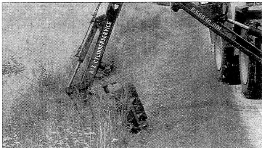
Figur 55. Vegkanter klippes årlig for å hindre oppslag av kratt. Klippetidspunkt og -høyde er vesentlig for sammensetningen av floraen.
