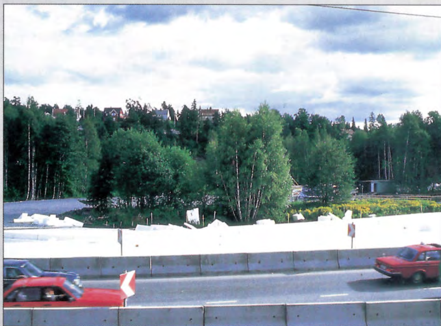
Figur 22. Eksisterende vegetasjon har stor estetisk verdi samtidig som kostnader til etablering og vedlikehold av nytt grøntanlegg reduseres (Lysaker-krysset, E18 Oslo).
