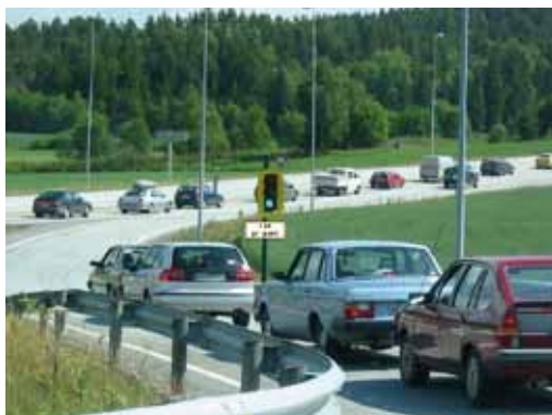
Figur 17 Anlegg for rampekontroll
