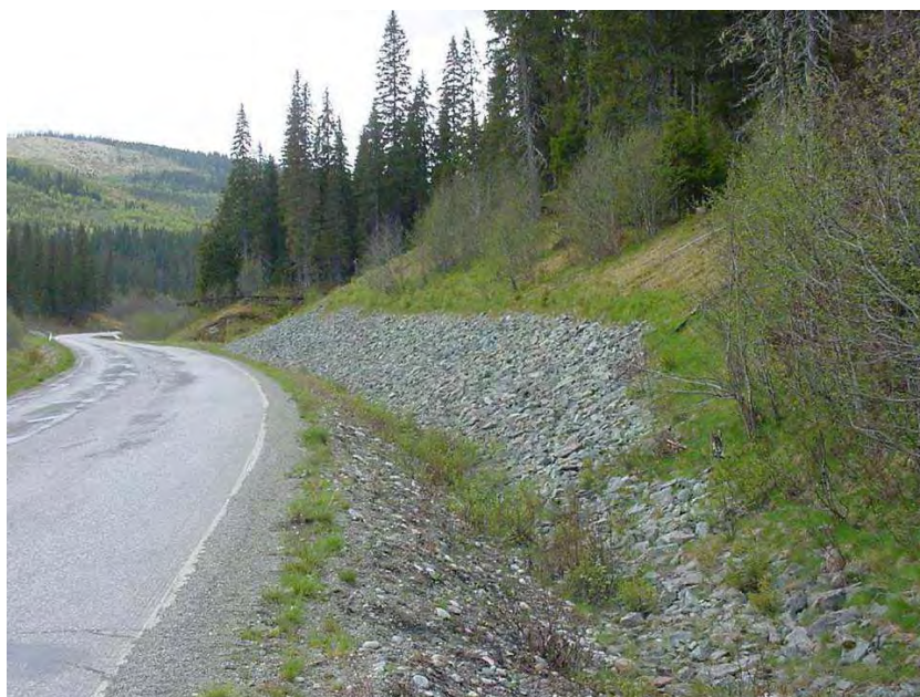
Figur 245.6 Masseutskifting i skråningsfot (Gartland i Nord-Trøndelag. Foto: Kjell Eriksen)
