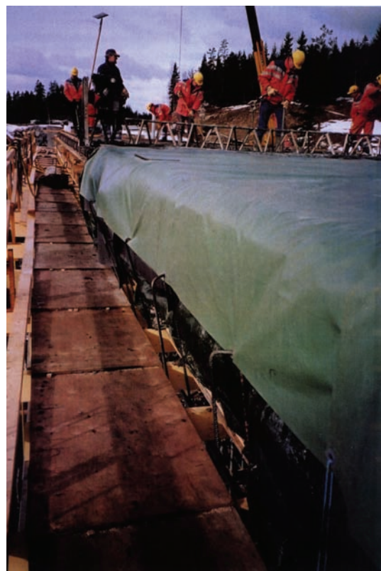
Fig. 3.8 Utprøving av prosedyre for å unngå plastisk svinn i brudekker.
