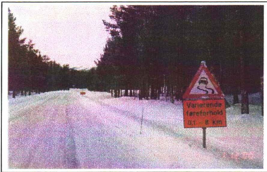
Figur 3.1: Eksempel på skilting av forsøksstrekning. Skilt 116 med undertekst. Den andre skiltkombinasjonen sees i bakgrunnen.
