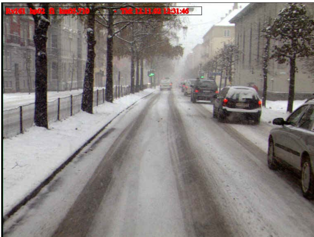
Figur VI.2: Rv 161, ny asfalt
