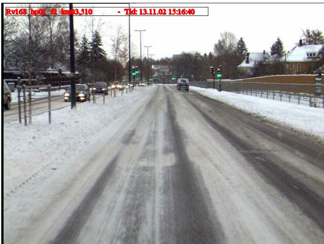
Figur VI.18: Rv 168, ny asfalt
