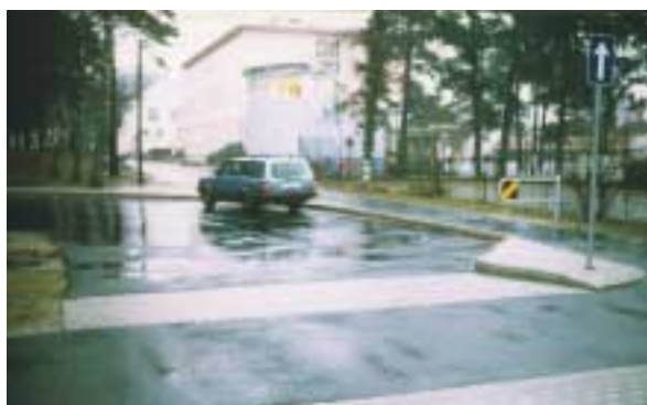
Oppramping for atkomst til snuplassen over gang-/sykkelvegen
