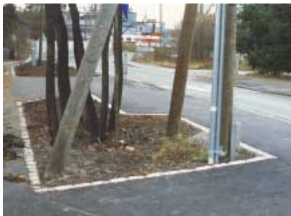
Fortausutvidelse med utsparing for trær og lysmast.
