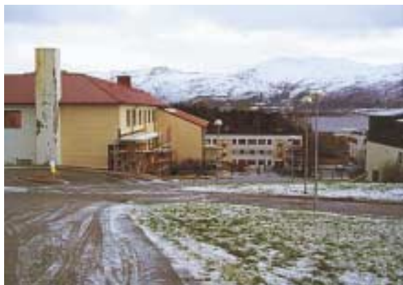
Ny inngang bygges nå (desember 99).
