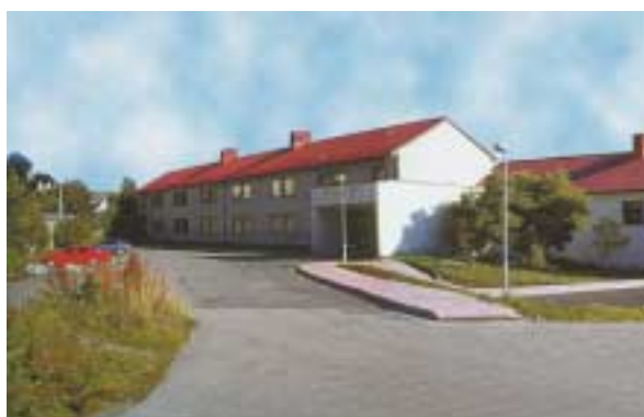
Snuplass med av- og påstigning, korttidsparkering og direkte atkomst til ny inngang for de yngste elevene via rampe. Den nye inngangen var ikke bygd da bildet ble tatt.
